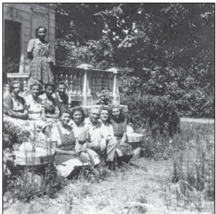
Munkások a terasz előtt, hátterben az épület Arbeiter vor der Terrasse, im Hintergrund das Gebäude
