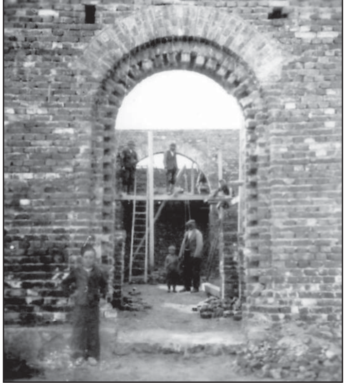
Az evangélikus templomot építik 1952-ben Der Bau der evangelischen Kirche 1952
