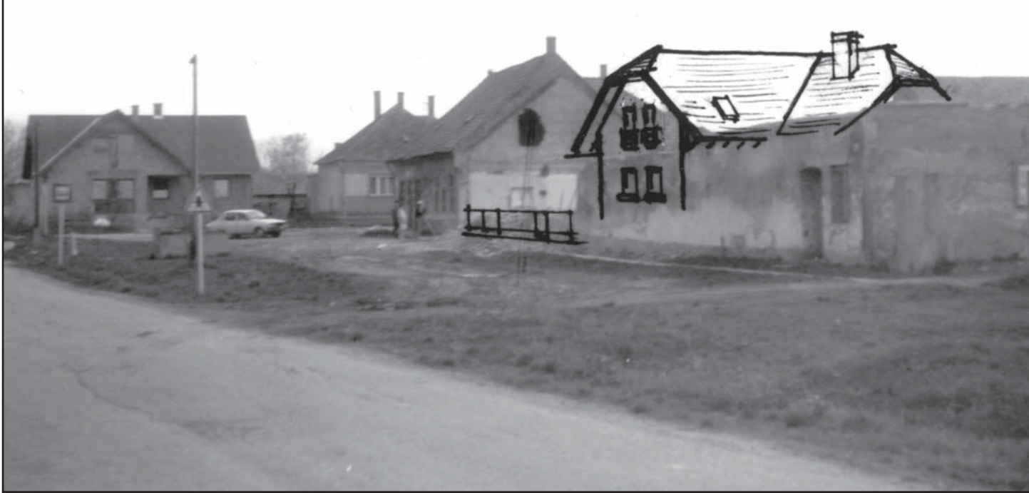
A Korn család gazdasági épületei bontás előtt 1989-ben Die Wirtschaftsgebäude der Familie Korn vor dem Abbruch 1989
