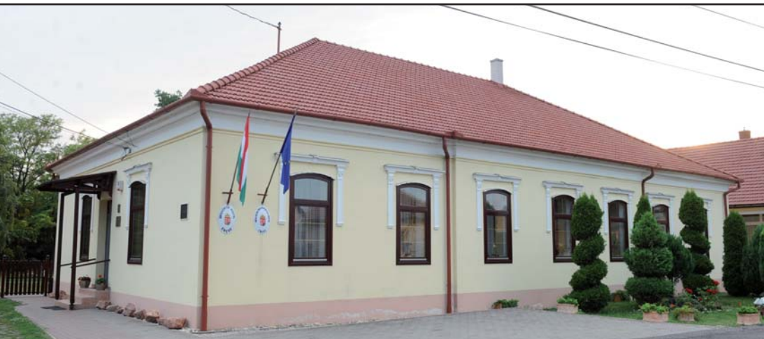
Utcai front Die Strassenseite
